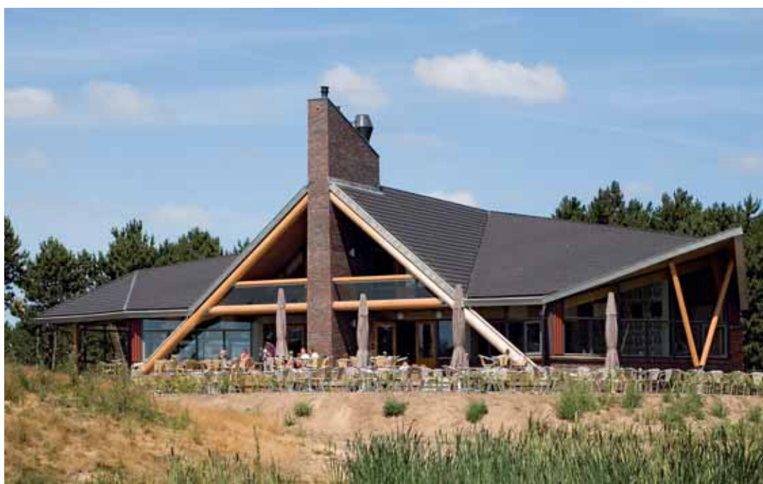
Terras aan de achterkant. Buiten accentueert lariks rondhout de kapvorm.
