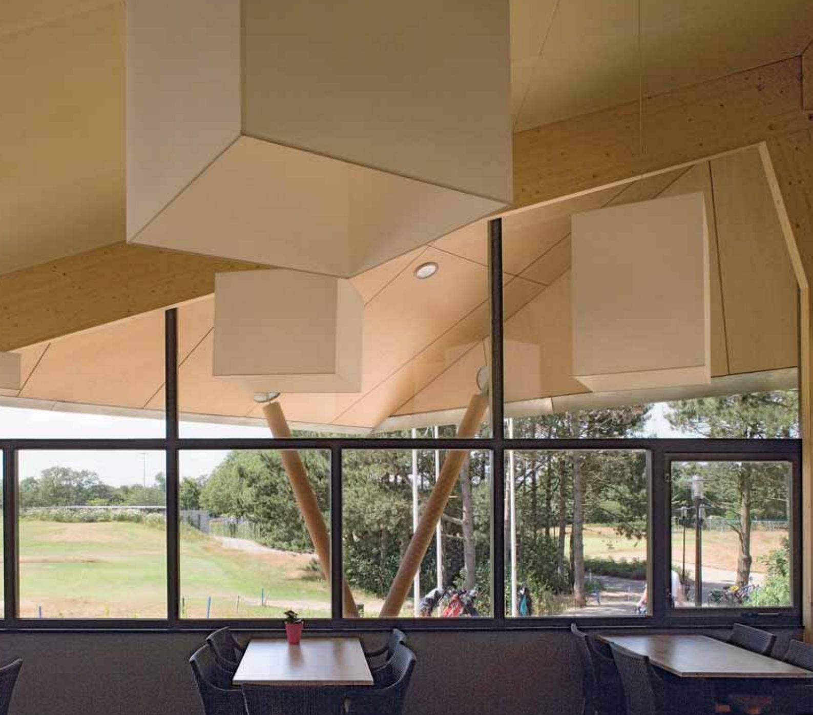
De dakvlakken met wisselende hellingen, afgetimmerd met berkentriplex, zijn ook zichtbaar in het restaurant.
